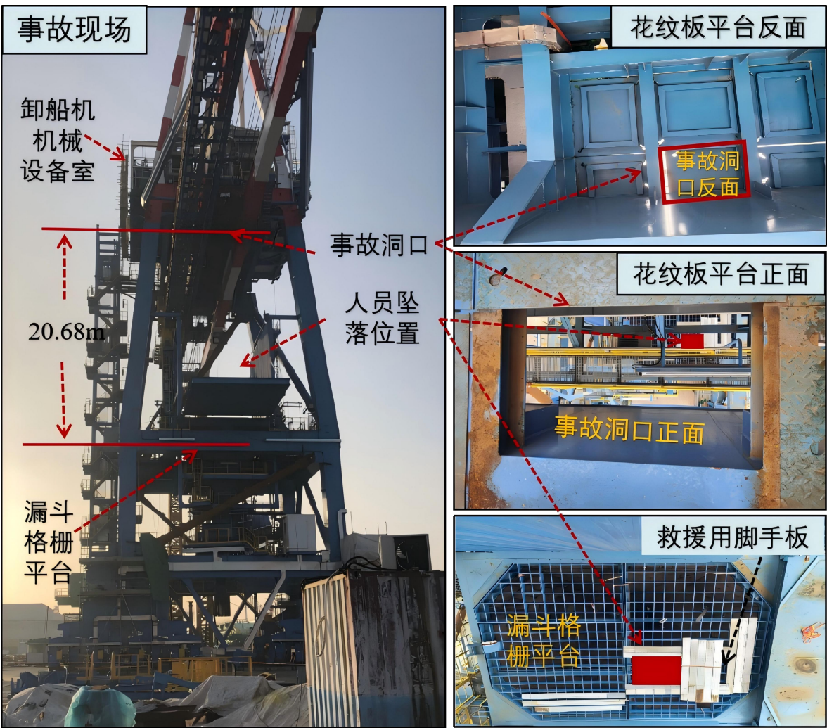
图 3 事故洞口及漏斗格栅平台
