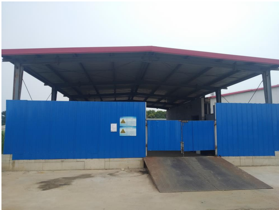
图 2 危险废弃物暂存场所
